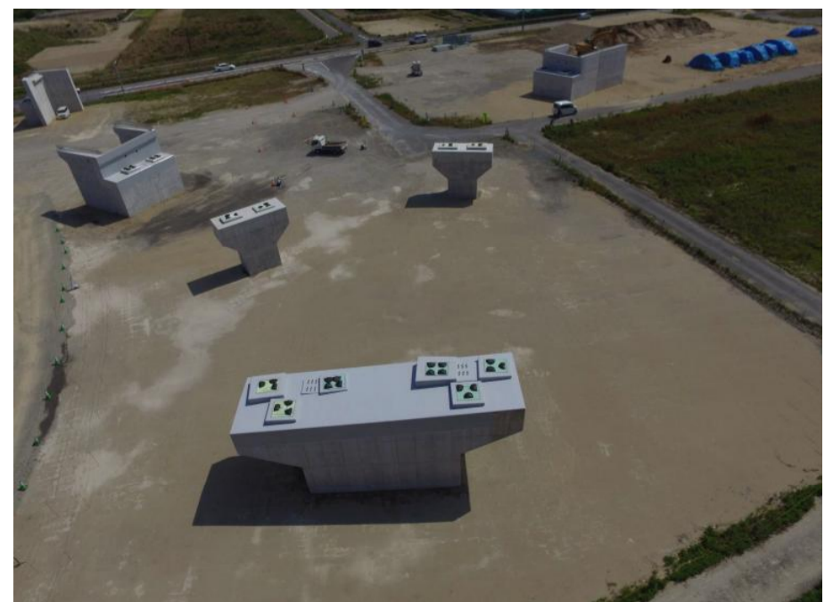
施工状況（北側から望む）
