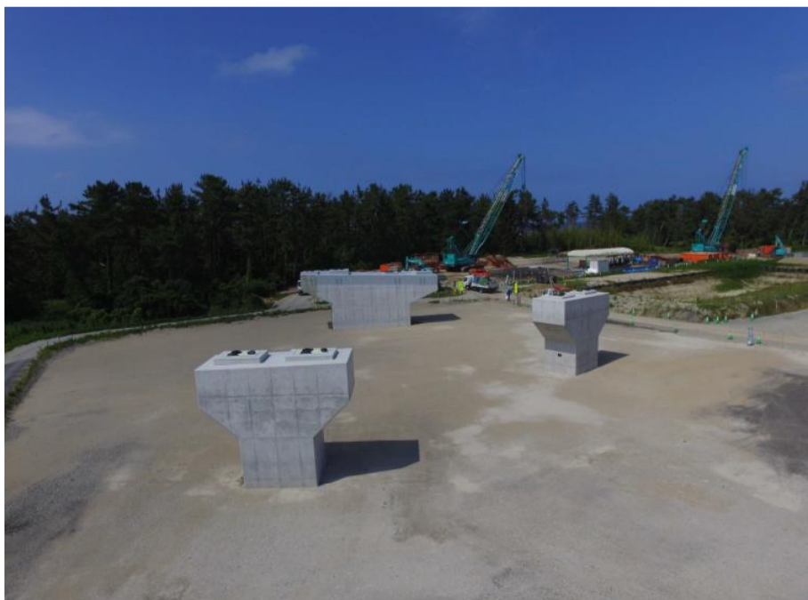
施工状況（南側から望む）
