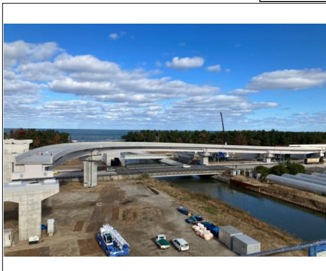
完成状況(令和5年12月中旬撮影)
