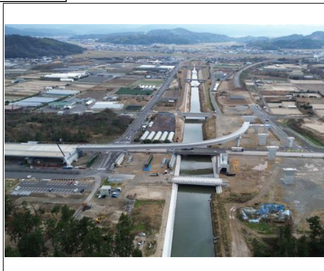
完成状況(令和5年12月末撮影)
