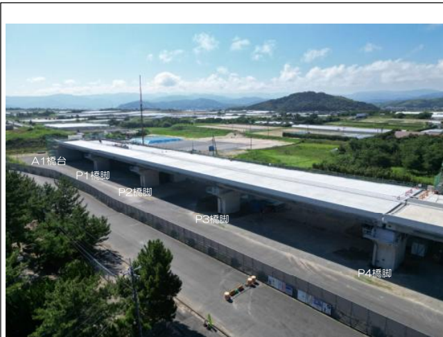
施工状況（上空米子側より全景）
