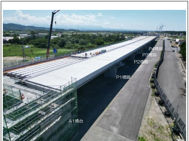
施工状況（上空鳥取側より全景）
