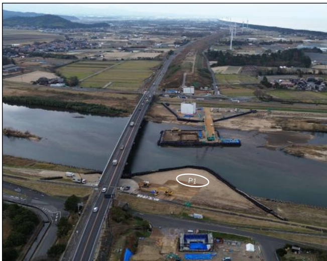
起点側 (湯梨浜町はわい長瀬より)
