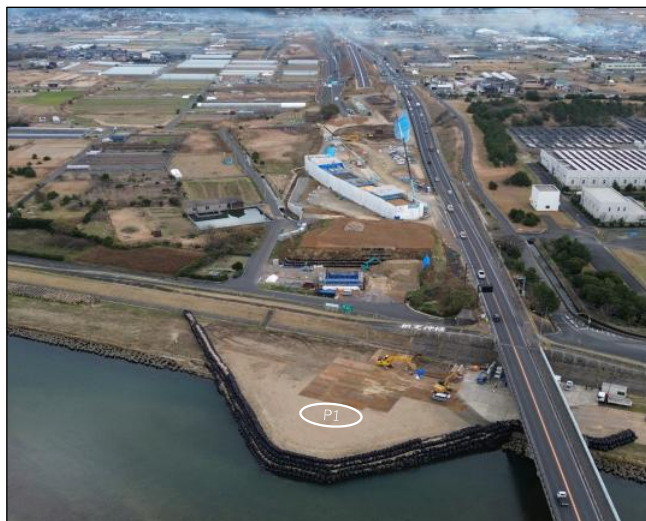
終点側 (北栄町江北より)
