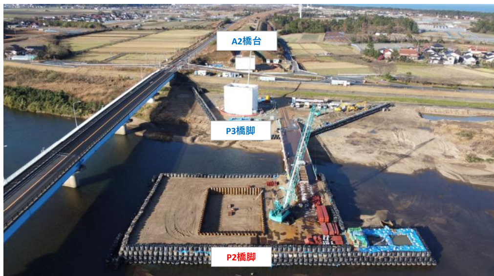
進捗状況写真
