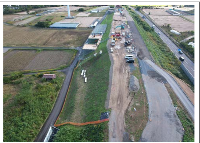
工事現場西側より撮影
