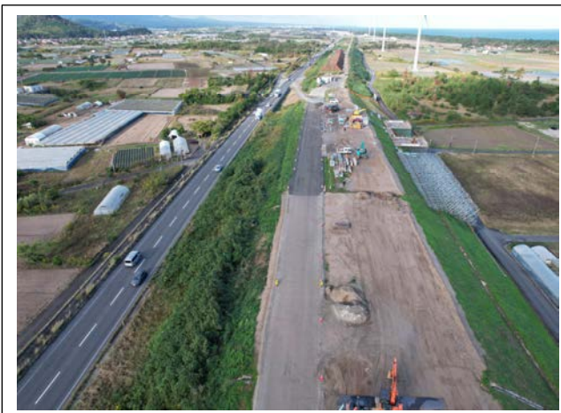
工事現場東側より撮影
