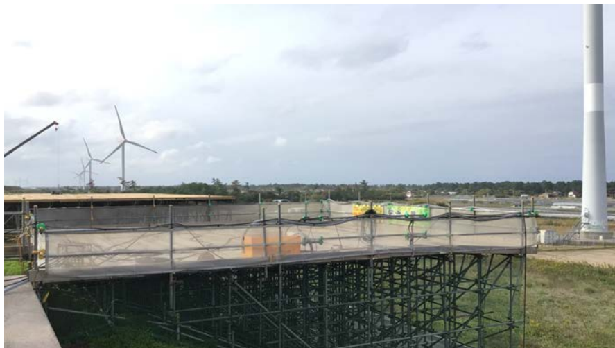
令和6年10月末（江北地区第3地盤改良工事）
