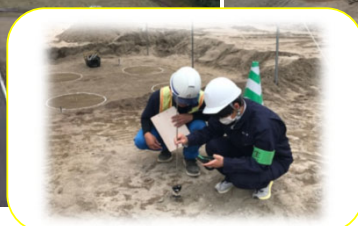
2号機 砂杭打込み中
