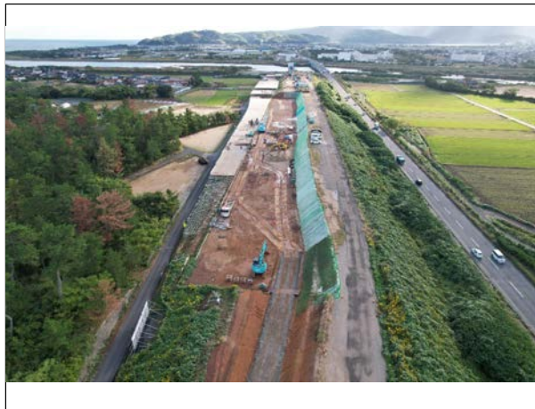
工事現場西側より撮影
