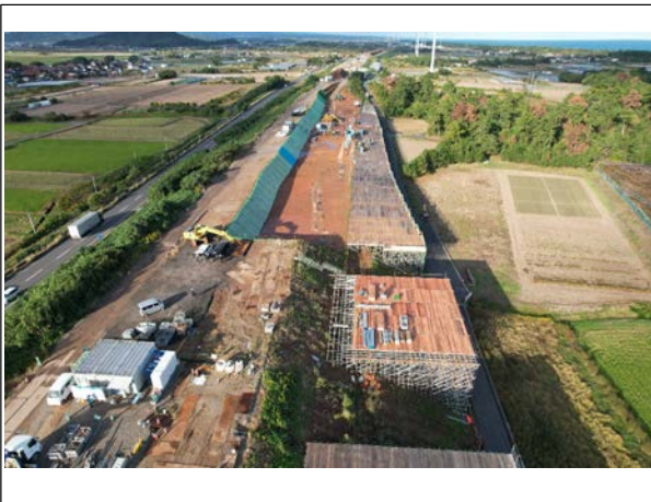
工事現場東側より撮影
