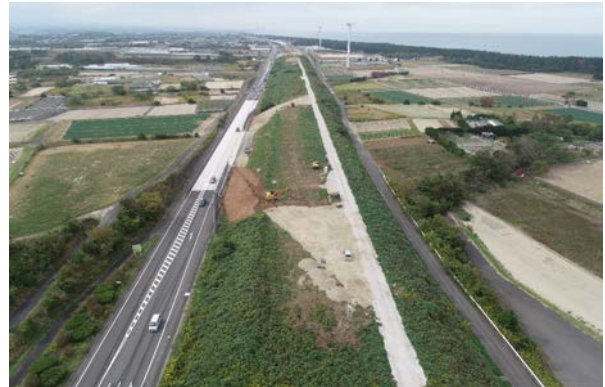
工事用坂路(2) 東側より
