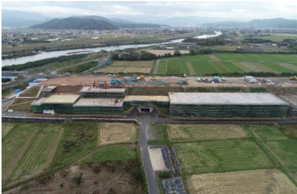
本体工事範囲 北側より
