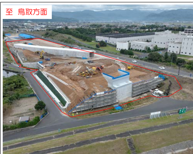
工事現場終点側より撮影
