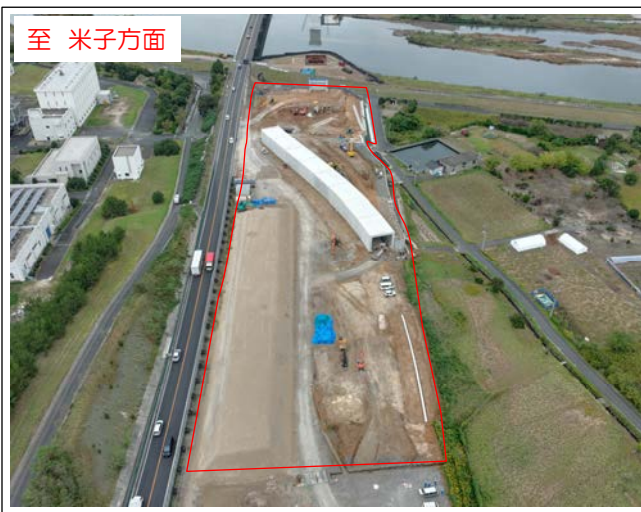
工事現場起点側より撮影
