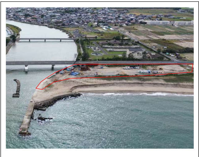
施工箇所（北側から南側撮影）
