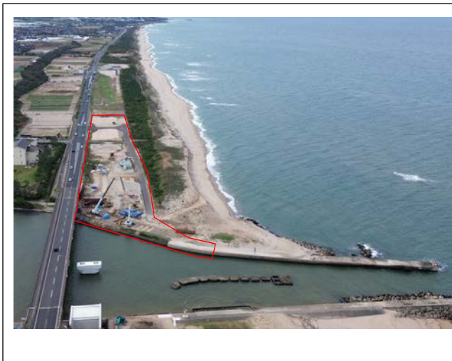
施工箇所（東側から西側撮影）
