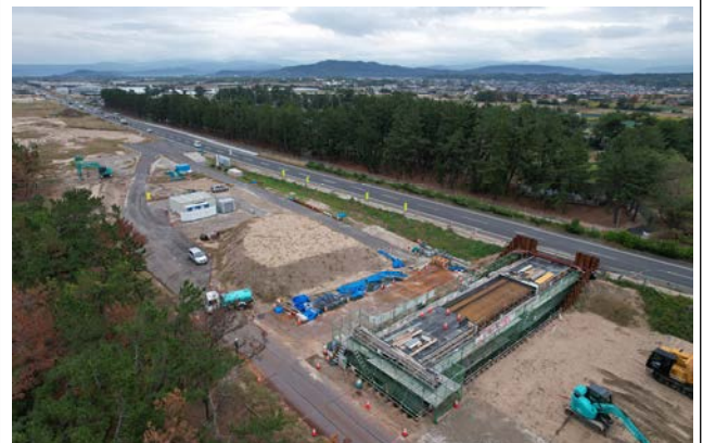
施工状況（1号場所打ち函渠）
