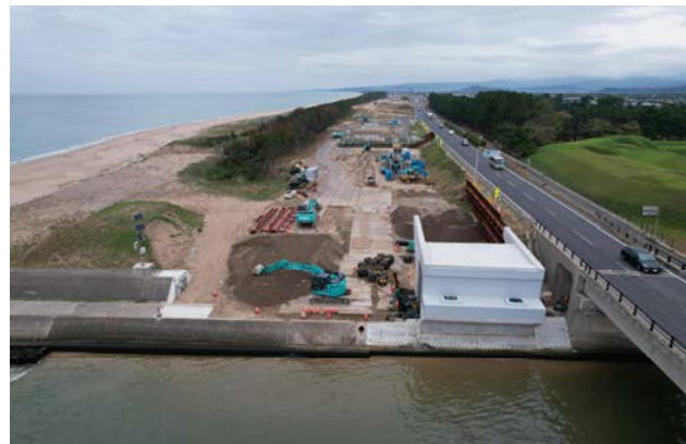
施工状況（A1橋台）
