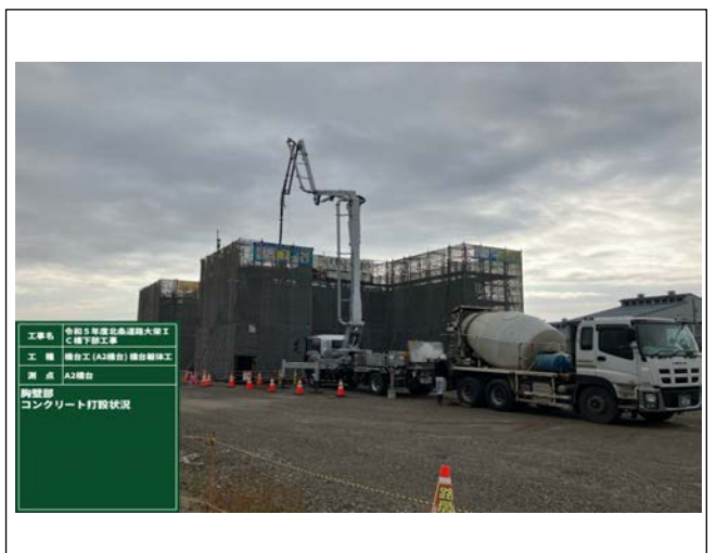
胸壁コンクリート打設
