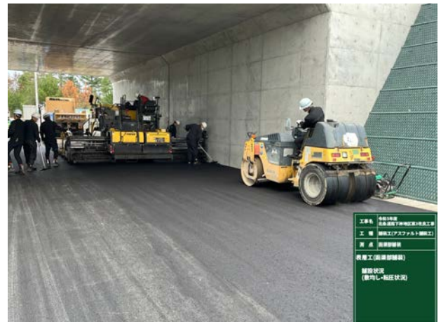
函渠部 表層舗設状況
