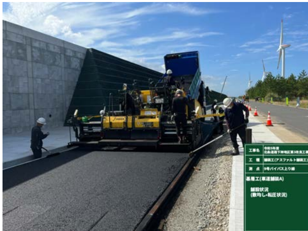
9号バイパス 基層舗設状況
