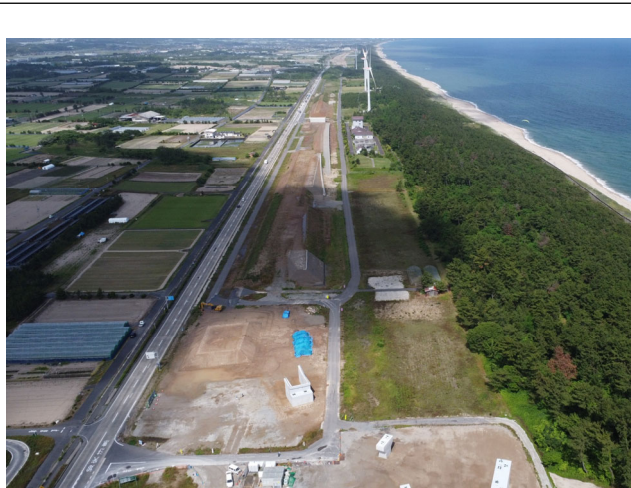
着工前(東側より)
