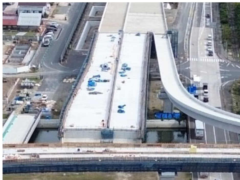
施工状況（米子側より）
