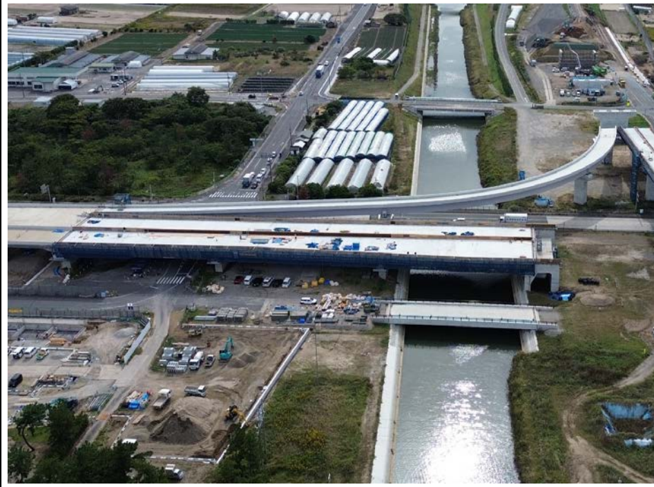
施工状況（海側より）
