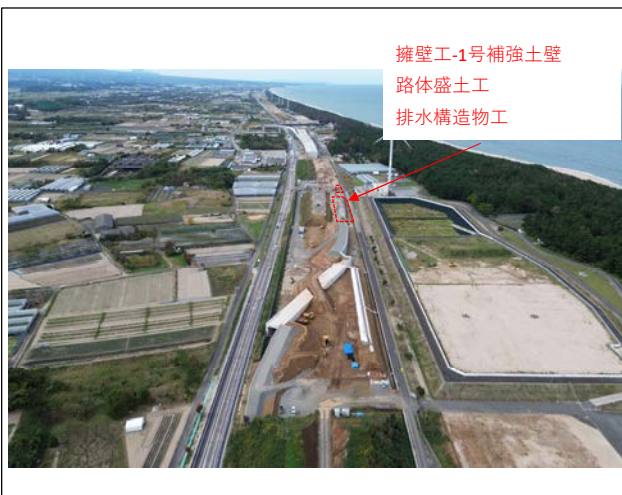
施工状況 (国坂)
