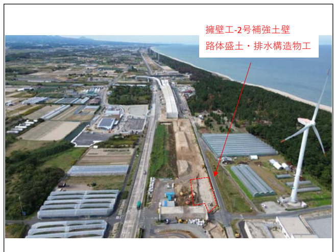
施工状況 (国坂)
