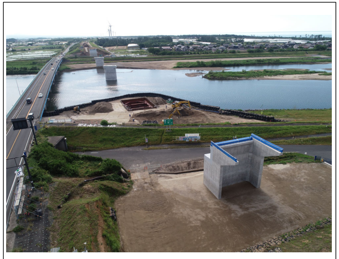
5月末時点（A1橋台側からA2橋台方向を望む）全景
