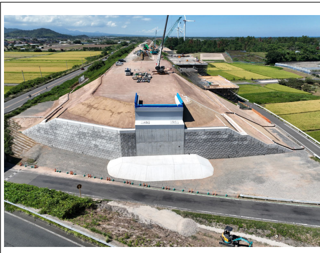
9月末 工事完了状況 全景
