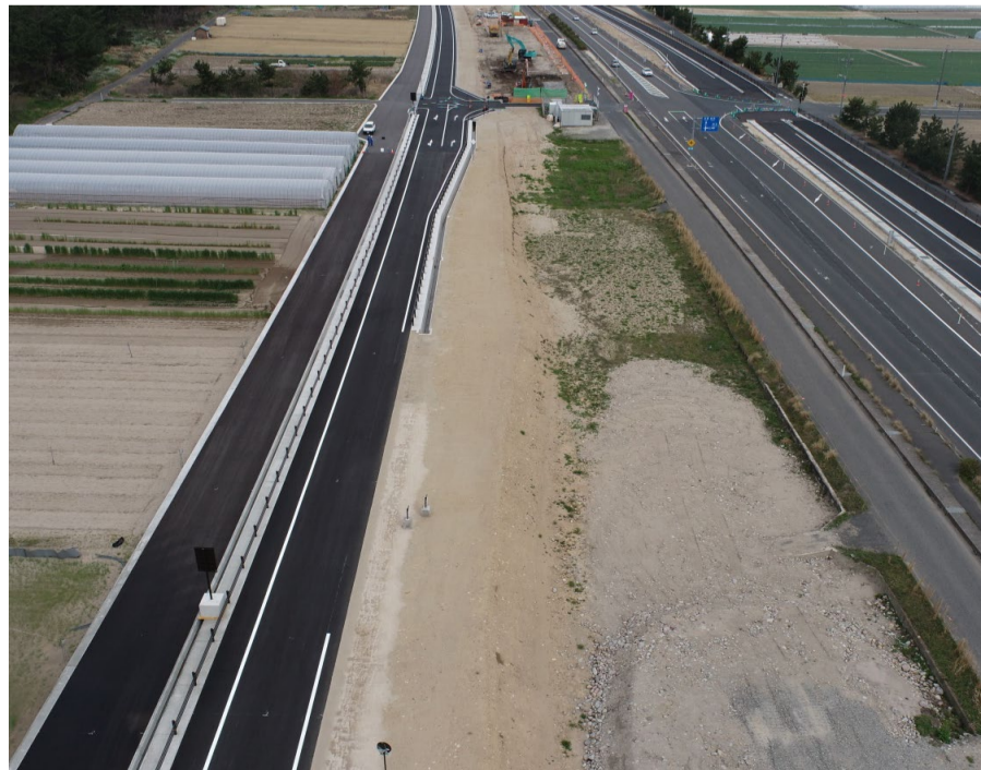
施工箇所 (北栄町西園) 西側より
