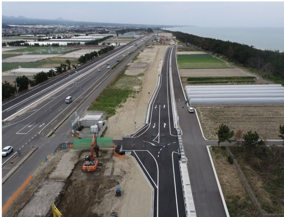
施工箇所 (北栄町西園) 東側より
