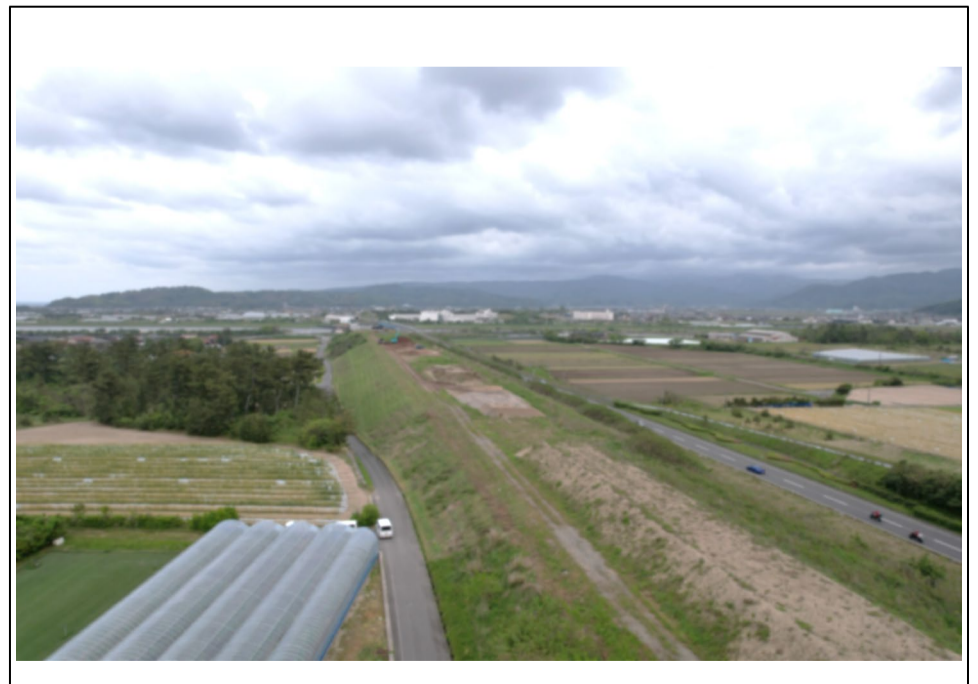
工事現場西側より撮影
