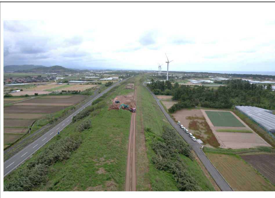
工事現場東側より撮影
