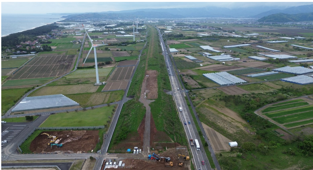
工事用道路（国坂）西側より
