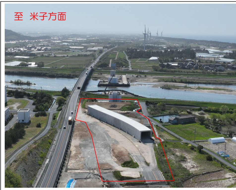
工事現場起点側より撮影
