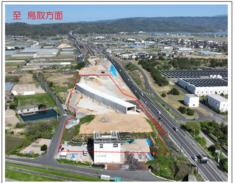
工事現場終点側より撮影
