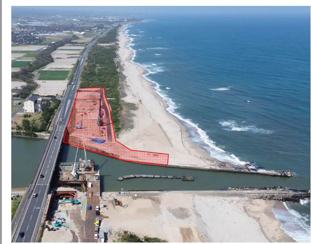
施工箇所（東側から西側撮影）
