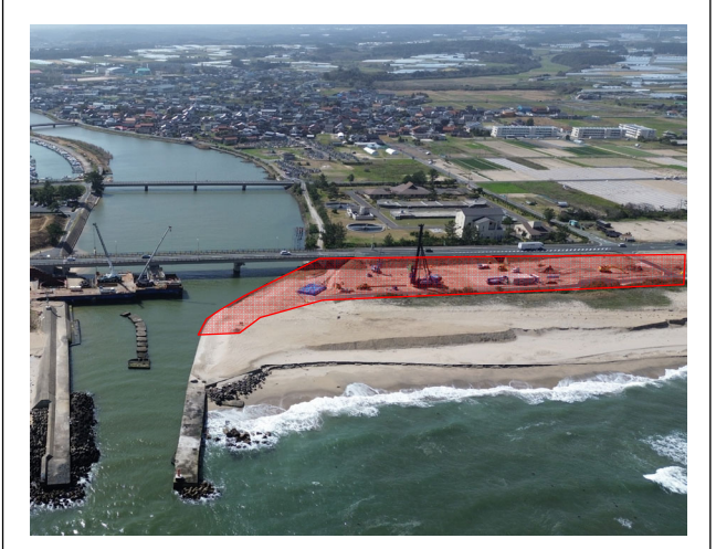
施工箇所（北側から南側撮影）
