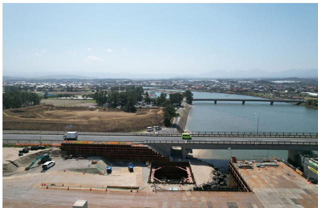
施工状況（A1橋台）
