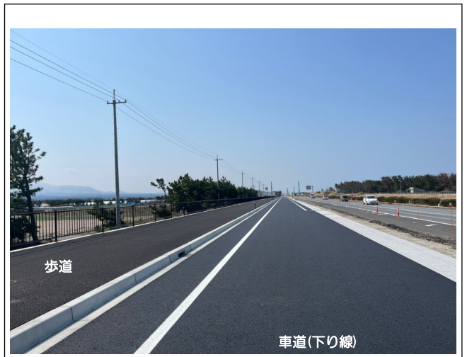
施工箇所 (北栄町西園) 起点側より撮影
