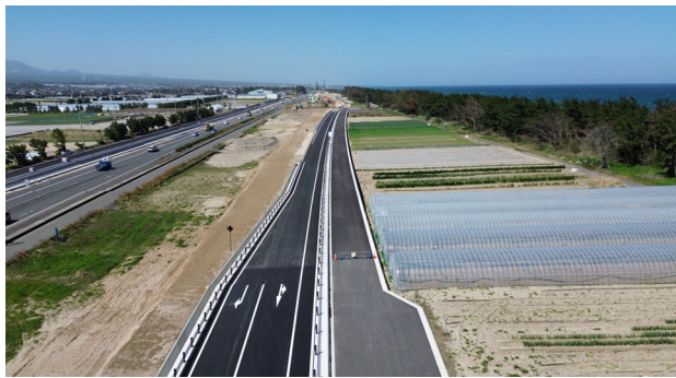
工事現場東側より撮影
