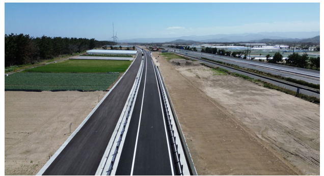
工事現場西側より撮影
