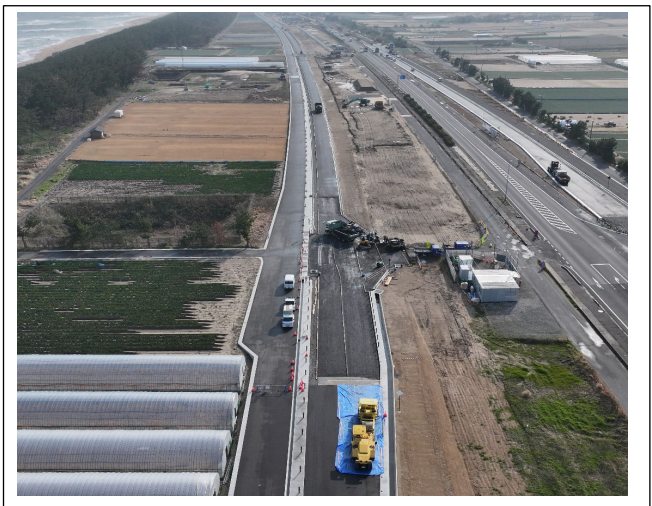
工事施工場所 西側より(北栄町西園)
