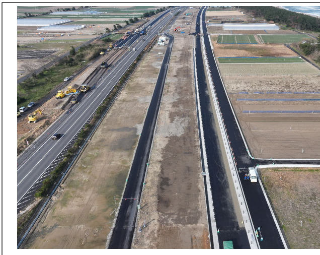
工事施工場所 東側より(北栄町東園)
