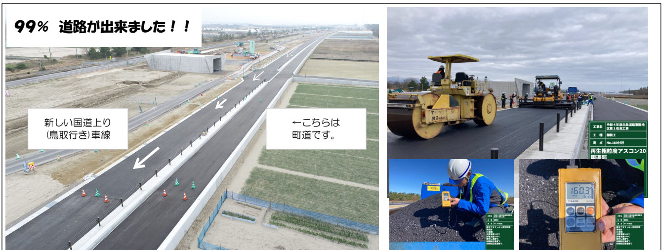
作業範囲の全景（ドローンにて）
