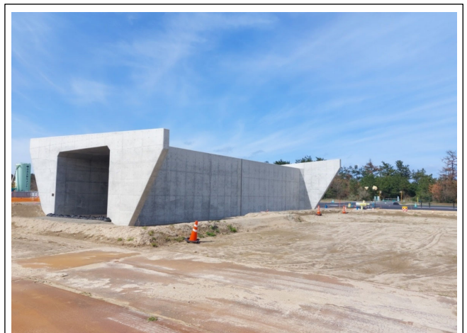
施工状況（東園地区）
