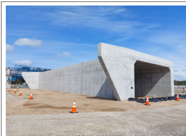
施工状況（弓原地区）
