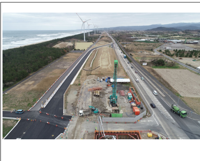
起点側 (松神地区)
