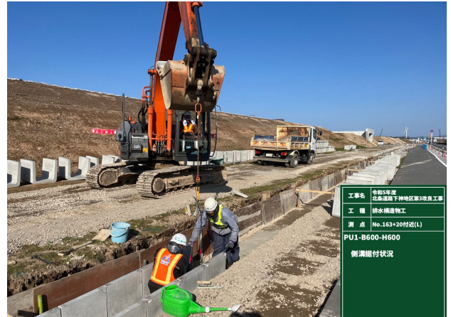
水路据付状況
