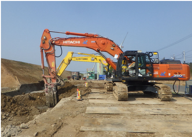
中層混合処理状況
