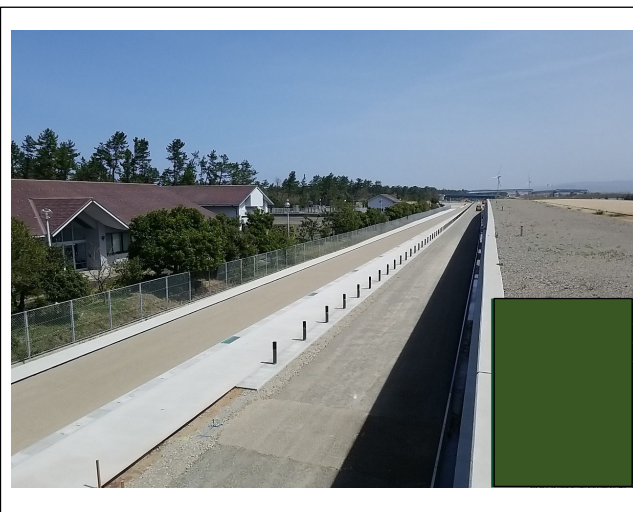
施工場所（西側より）
