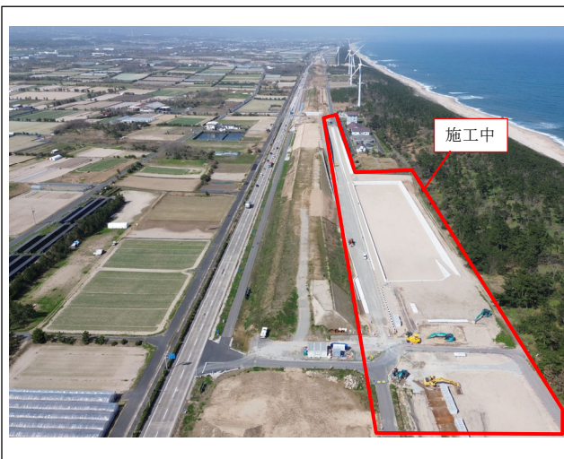
施工場所（東側より）
