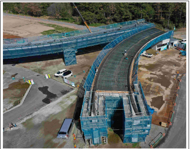
施工状況（令和6年3月29日撮影）
