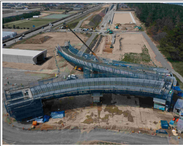
施工状況（令和6年3月14日撮影）
