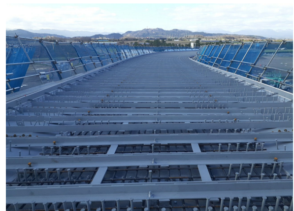
橋桁上（床版設置完了）
