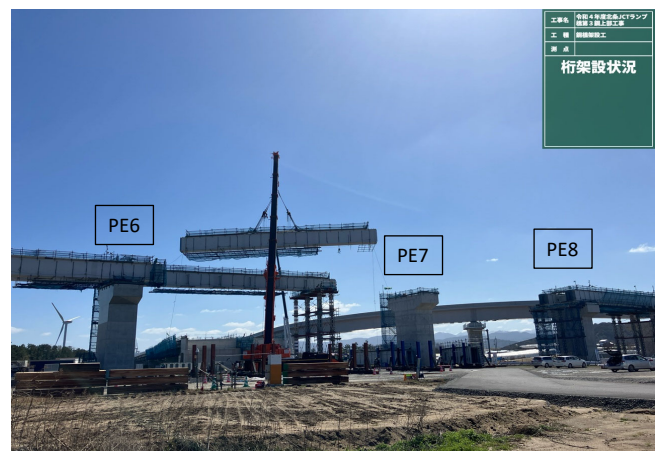
施工状況 (桁架設)
