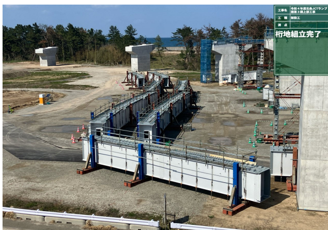
施工状況 (桁地組立)
