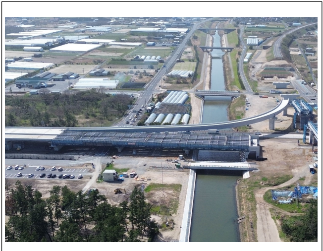
施工状況（海側より）
