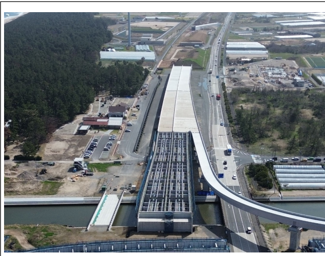
施工状況（米子方面より）
