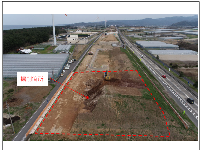
施工状況（国坂）
