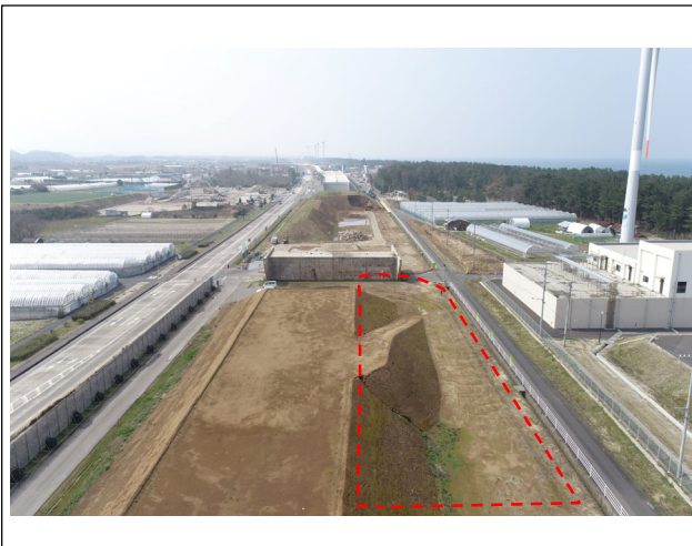
施工状況（国坂）
