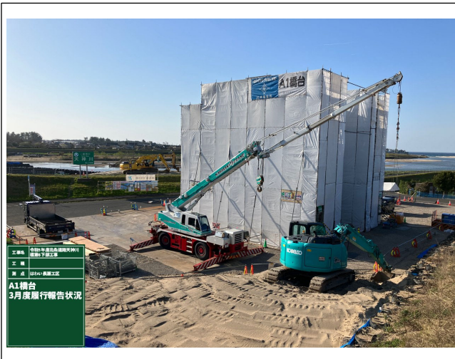
3月末現場状況（湯梨浜工区 A1側）
