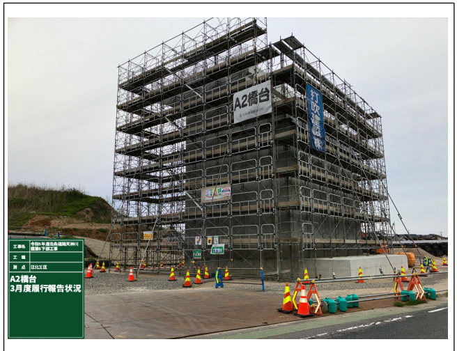
3月末現場状況（北栄工区 A2側）
