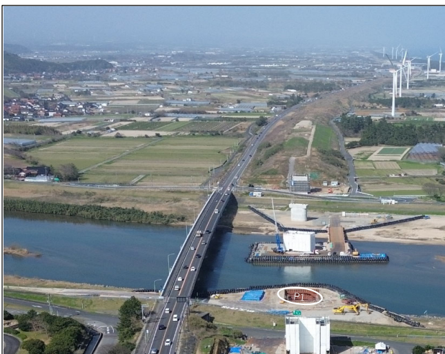
起点側（湯梨浜町はわい長瀬より）
