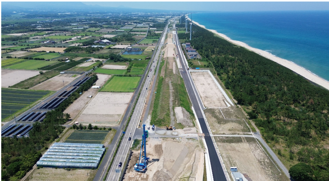
進捗状況写真
