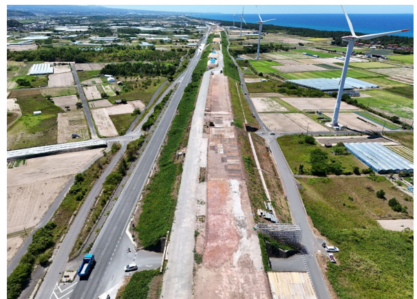
本体工事範囲 東側より
