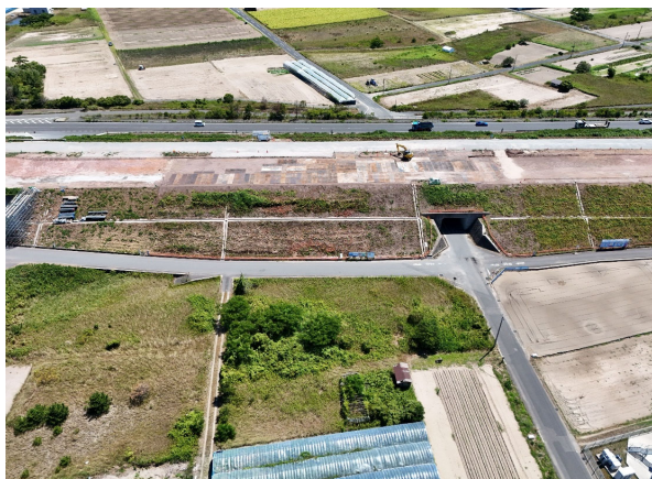
本体工事範囲 北側より
