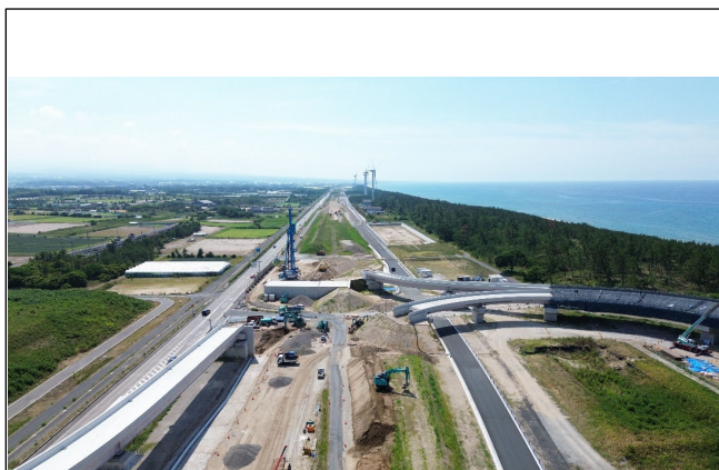
工事現場東側より撮影
