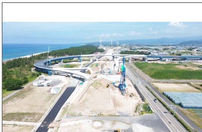
工事現場西側より撮影
