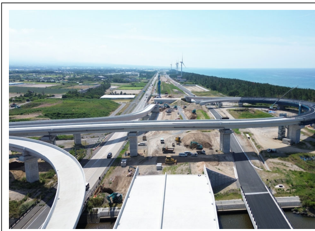
工事現場東側より撮影
