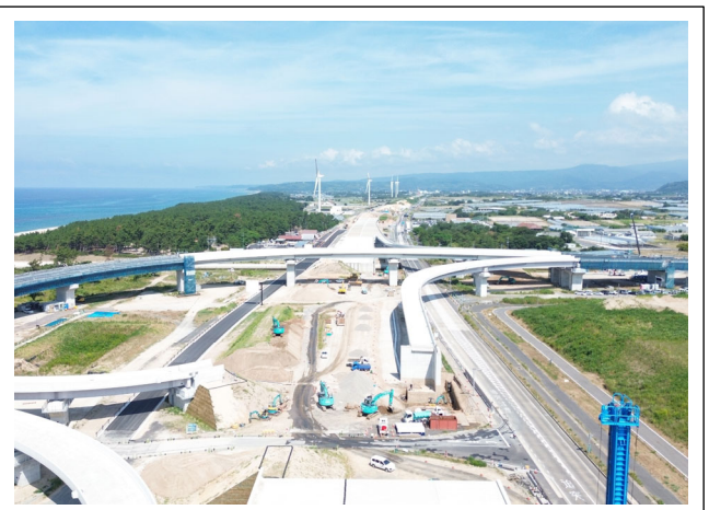
工事現場西側より撮影
