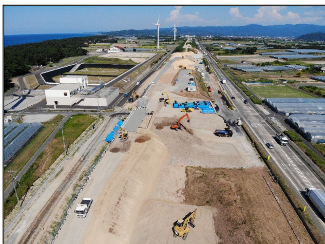
工事現場西側より撮影
