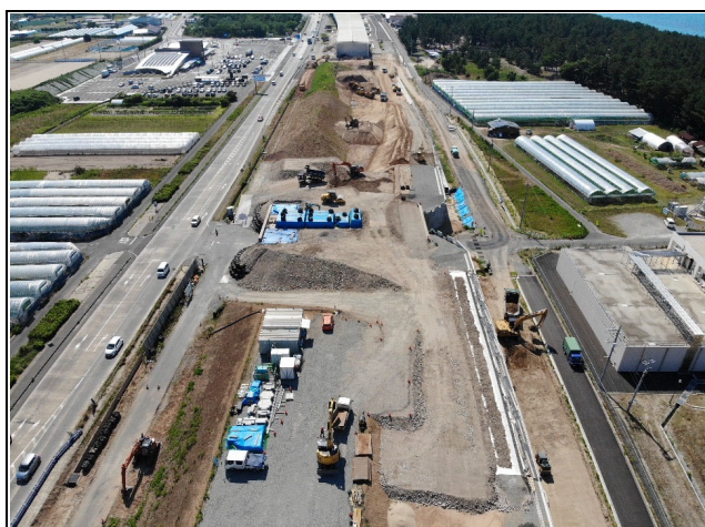
工事現場東側より撮影
