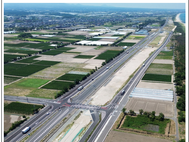
国道9号上り線(東側より撮影)
