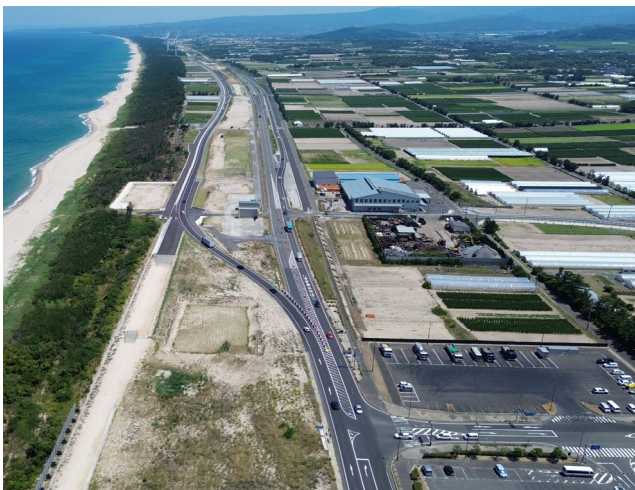
国道9号上り線セパレート接続部(西より撮影)
