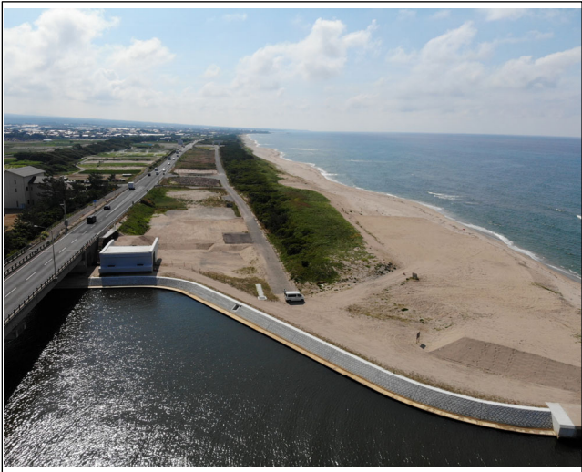
施工箇所（東側から西側撮影）
