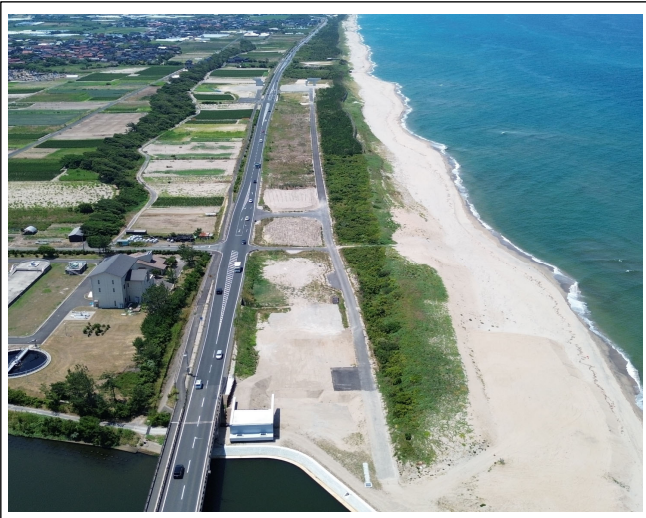
施工箇所（東側から西側撮影）
