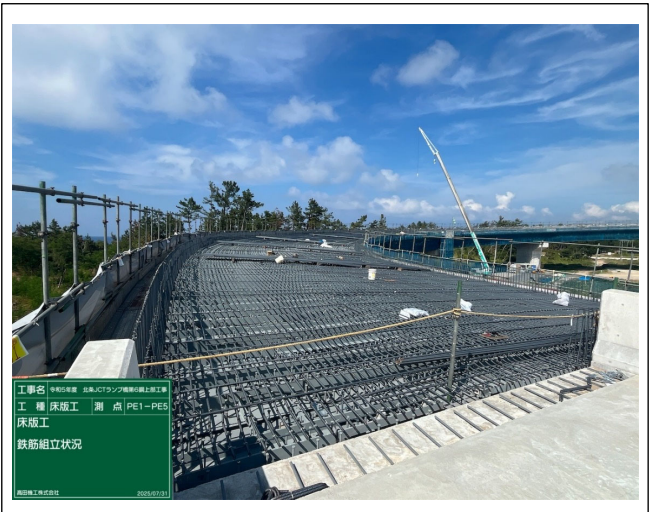
床版鉄筋組立状況
