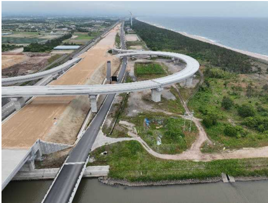
令和8年5月(着工前写真)
