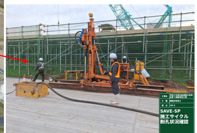
静的圧入締固め工法（SP工法）
