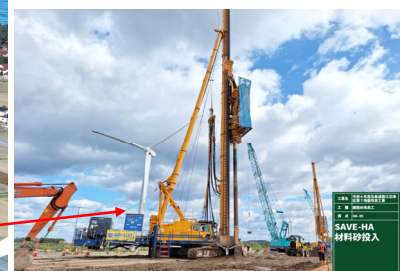
静的締固め工法（HA工法）
